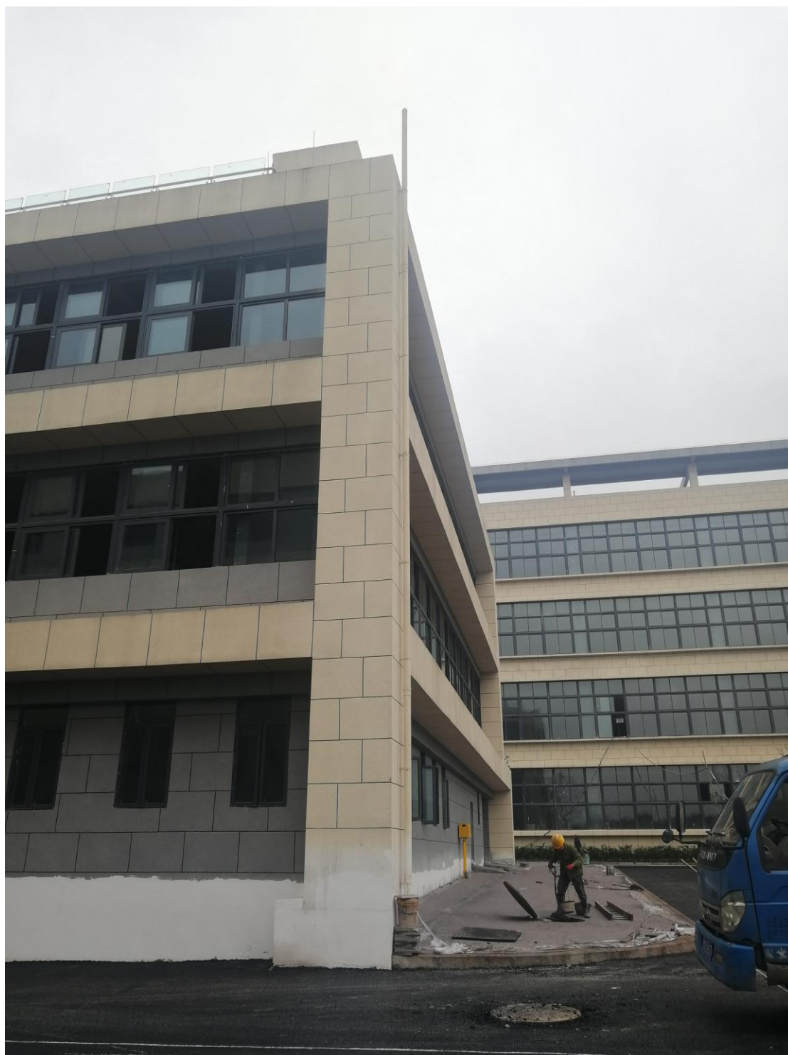
生化池臭气排气筒
